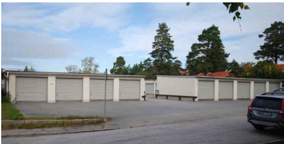
De fyra vinkelställda garagelängorna i kvarteret Fröja byggdes 1960. På senare år har de dock renoverats och målats om och den karaktäristiska 1950/60-talsprägel är därför inte längre lika påtaglig.
